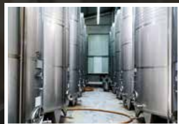
TANQUES DE ALMACENAMIENTO
